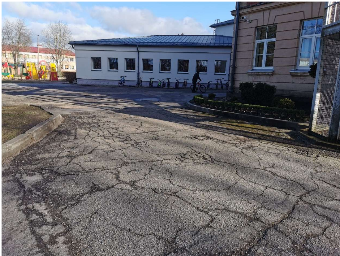
Skats no pieslēguma ceļa
